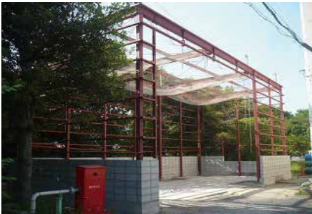
倉庫改修工事
