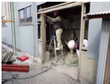
倉庫前 両開き扉改修工事
