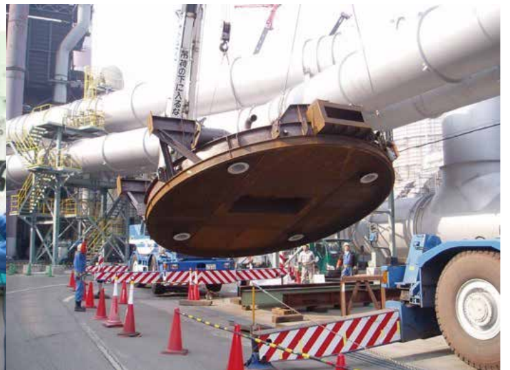
バケット着床粉塵対策 炉蓋製作・設置 寸法：φ6225×H589
