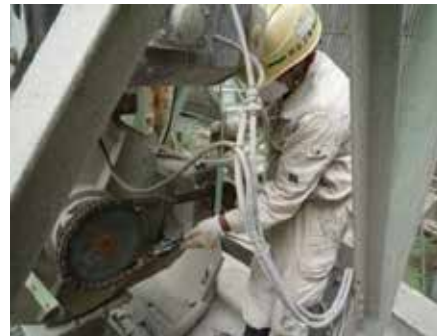
バケットエレベーター回り 点検歩廊 床板張替
