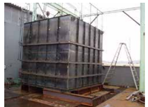
30 m 3 水貯蔵タンク 寸法：W2600×D3000×H3000
