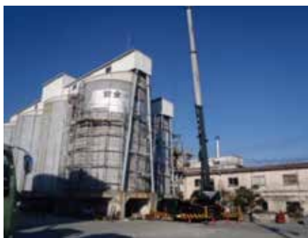
コールゲートサイロ側面鉄板張替 (パッチ当て)
