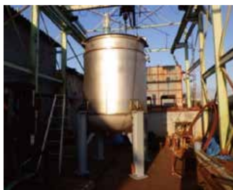
溶剤タンク / タンク周り作業用ステージ 寸法: 7 \text{ m}^3 \cdot 5 \text{ m}^3 タンク
