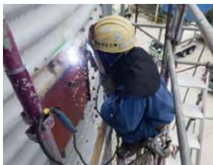
コールゲートサイロ側面鉄板張替 (パッチ当て)
