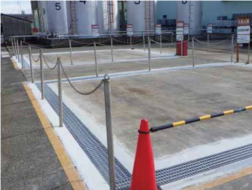
屋外ヤード側溝改修工事
