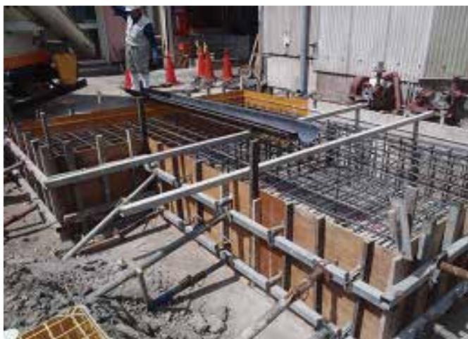
機械基礎工事
