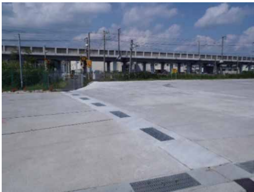
側溝 グレーチング改修工事
