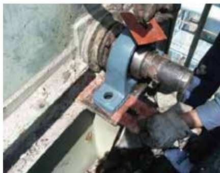
コールゲートサイロ側面鉄板張替 (パッチ当て)
