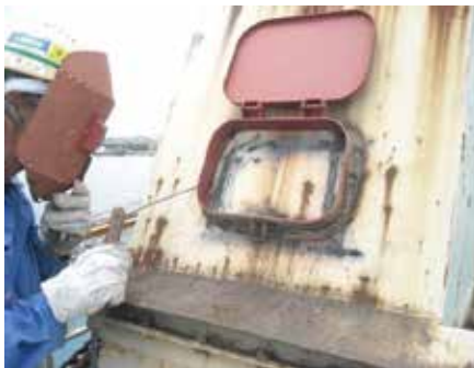
サイロ圧送バンド管補修・取替
