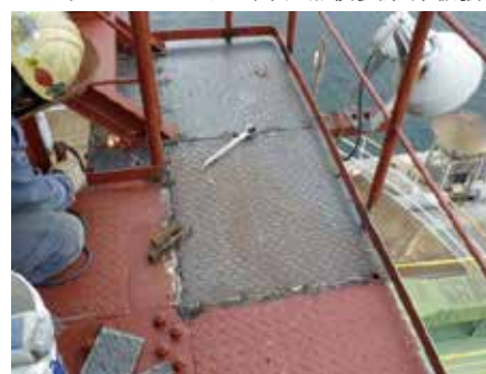
バケットエレベーター回り 点検歩廊 床板張替
