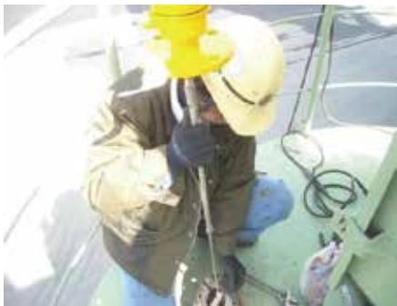
サイロ圧送バンド管補修・取替
