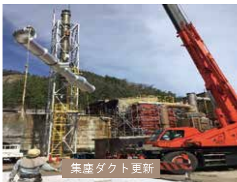
集塵機設置（足場仮設・保温工事）
