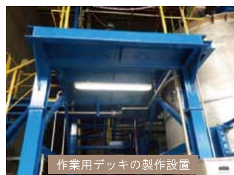
作業用デッキの製作設置
