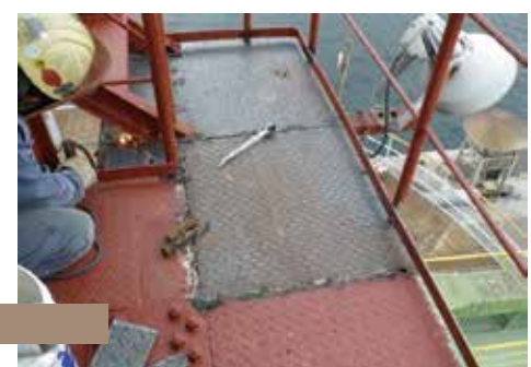
バケットエレベーター回り 点検歩廊 床板張替
