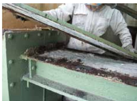
チェーンコンベア 内部セメント研り・補修
